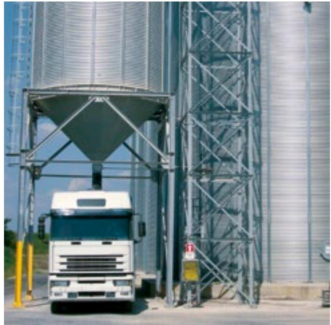
*Les silos de chargement en vrac CR sont utilisés pour le chargement des moyens de transport comme les camions et les trains.*
