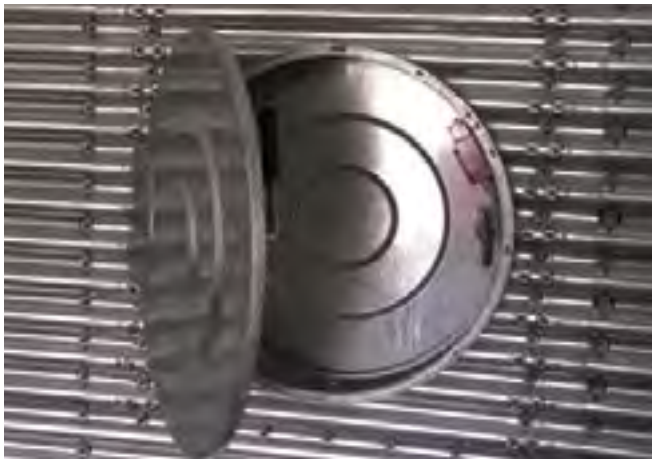
ENG. Detailed view of the double inspection door seen from the internal part of the silo FRA. Détail de la double porte vue de l'intérieur du silo ITA. Dettaglio della doppia porta vista dall'interno del silos
