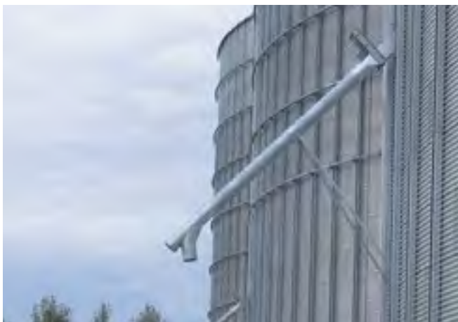
ENG. Detailed view of a silo with wind protection rings and side unloading channel FRA. Détail d'un silo avec anneaux anti-vent et décharge latérale ITA. Dettaglio di un silos con anelli antivento e scarico laterale
